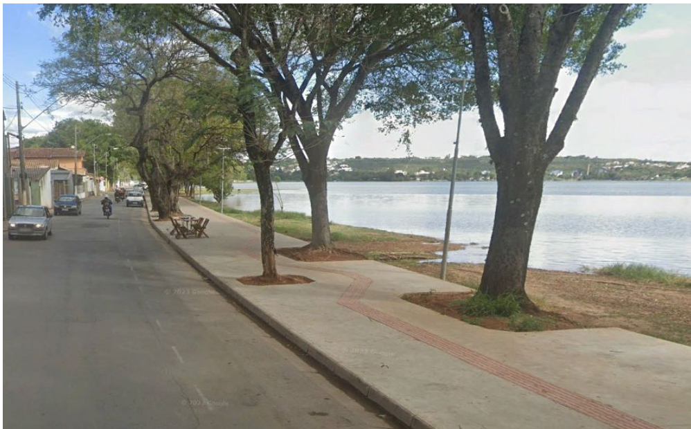
FIGURA 2 – VISTA DO LOCAL DA IMPLANTAÇÃO DO GRAMADO GOURMET
